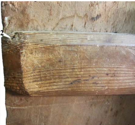
Figura 7 - Prelievo del campione n.2, traversa superiore
